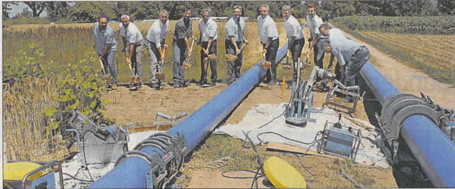
Symbolischer Spatenstich: Vertreter der Wasserversorger und des Tiefbauunternehmens Weiss.
