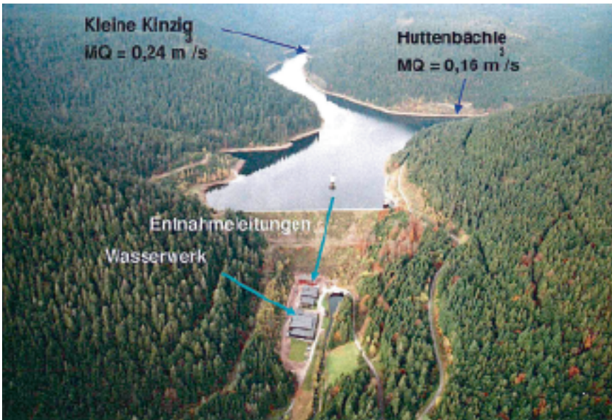
Bild 4: Trinkwassertalsperre Kleine Kinzig (Quelle: ZV Wasserversorgung Kleine Kinzig)
